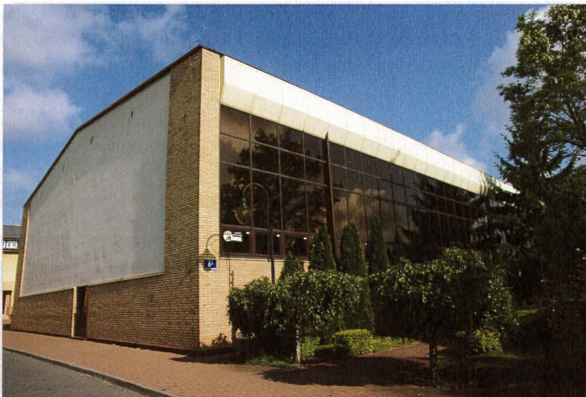
Budynek Hali Sportowo - Widowiskowej w Baboszewie.
