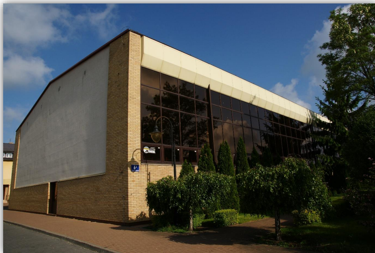
Rysunek 10. Budynek Hali Sportowo – Widowiskowej w Baboszewie.
