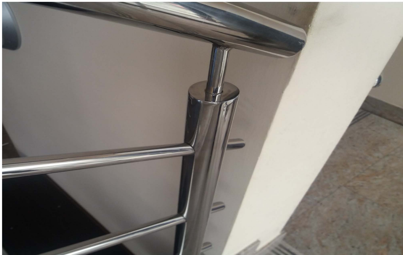
Rys. nr 2 - szczegół wykonania przelotki w barierce
